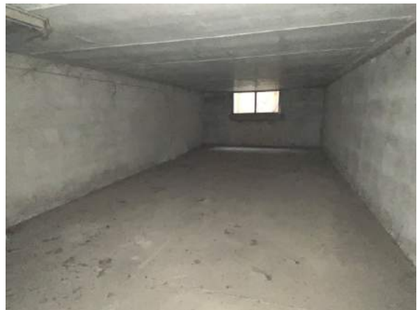
Vista interna autorimessa sub.28 piano interrato
