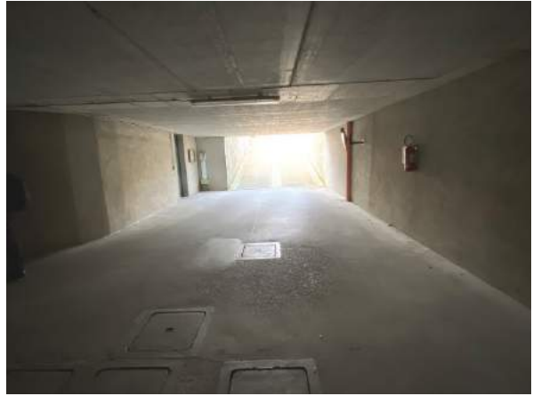
Vista corsello piano interrato
