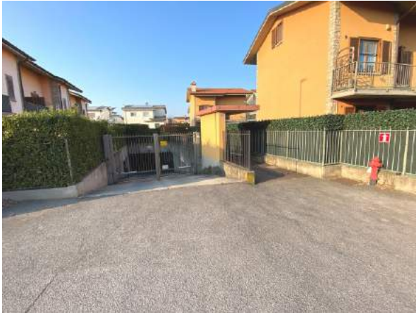
Vista ingresso carrale e pedonale corpo A-B-F
