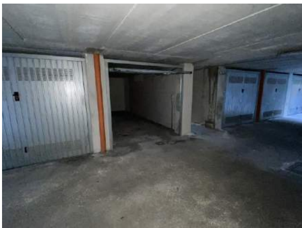
Vista autorimesse tipo piano interrato
