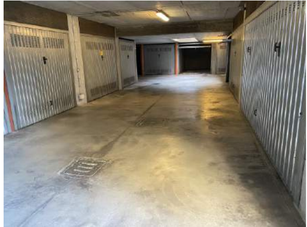
Vista corsello piano interrato
