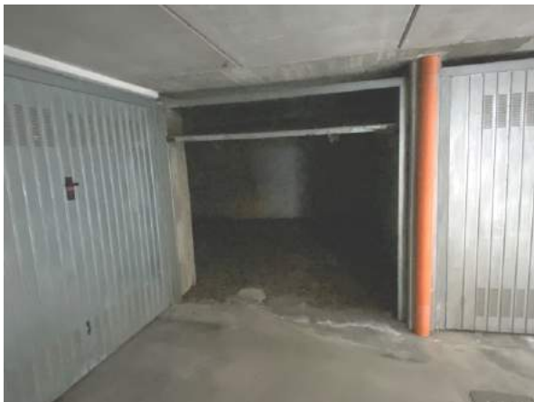
Vista autorimessa piano interrato
