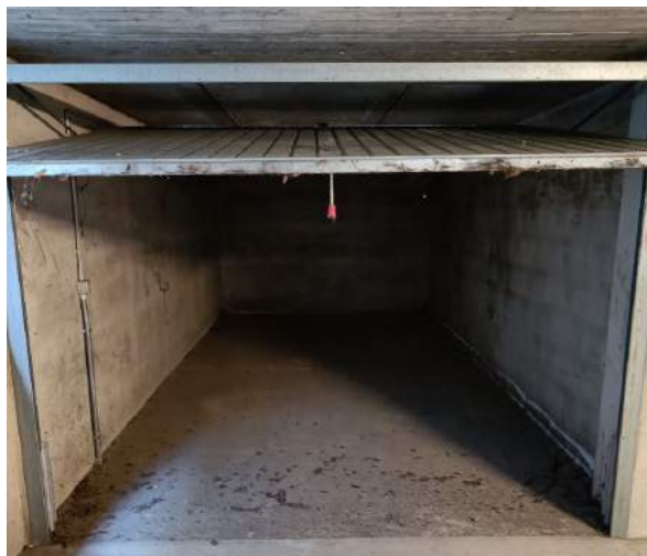
Vista autorimessa piano interrato
