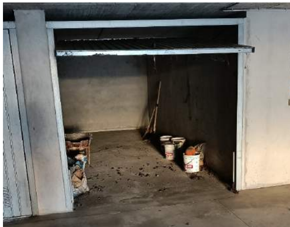
Vista autorimessa piano interrato
