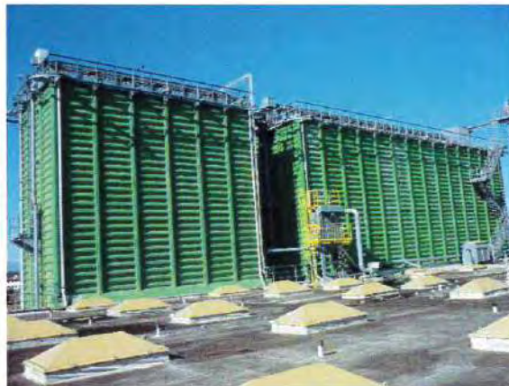
Altra vista delle due torri dell'impianto di insilaggio. Alla base ed a fianco di uno di essi, la tettoia per il carico/scarico dei vagoni ferroviari.
