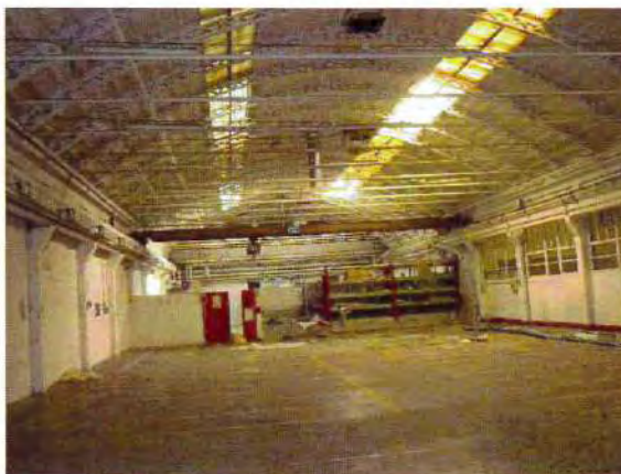
Viste contrapposte della terza campata (a partire da Sud) entro la quale scorre il carroponete della portata di 2mila chilogrammi.
