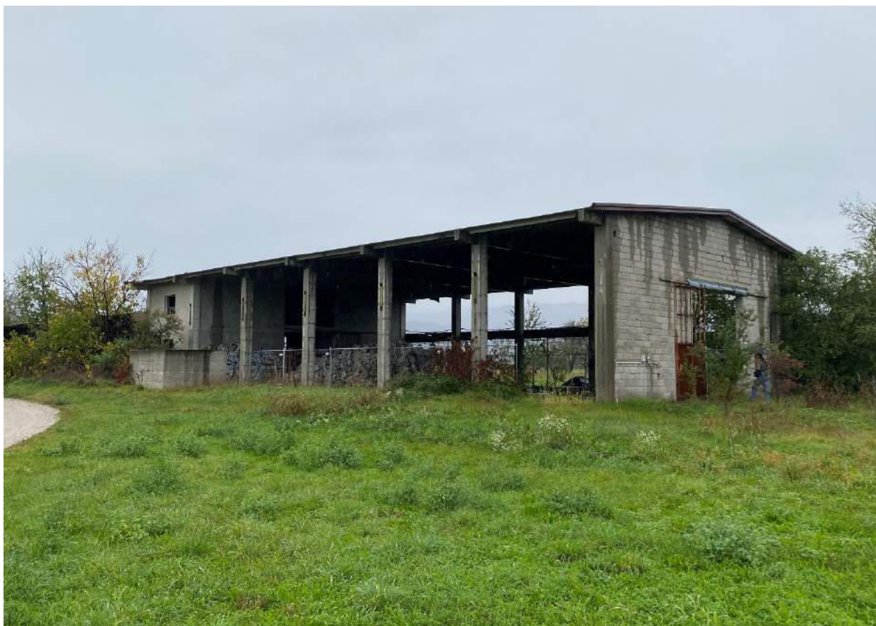
Foto 01 - Vista esterna Dep-Fienile
