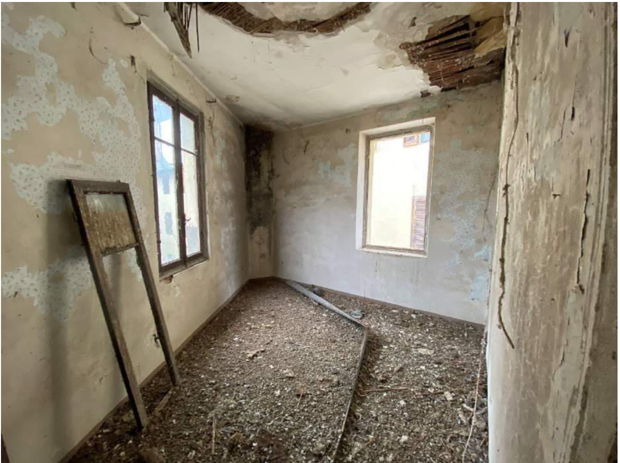
Foto 08 – Vista Interna P1 Camera1
