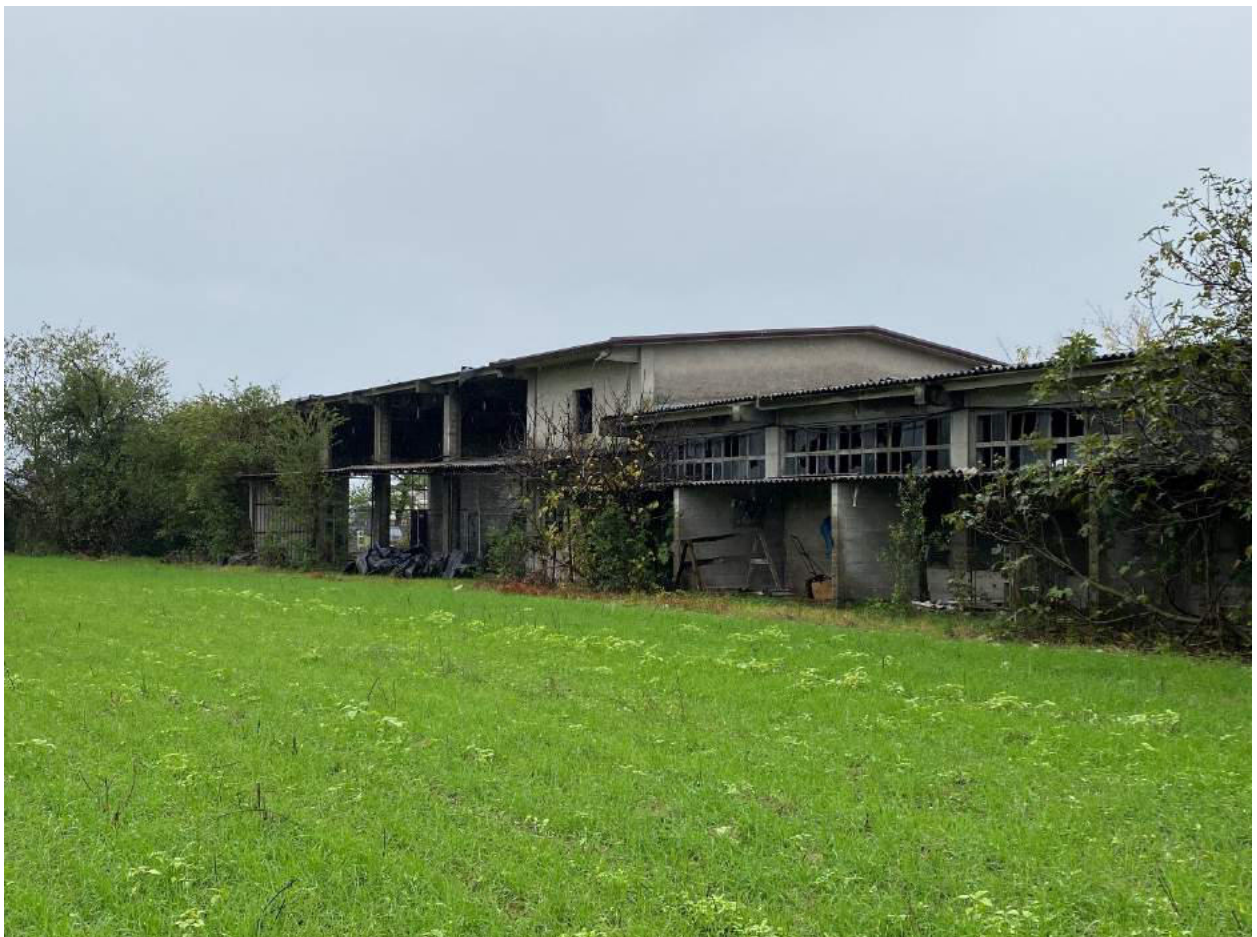
Foto 04 – Vista esterna Stalla Dep.Fienile
