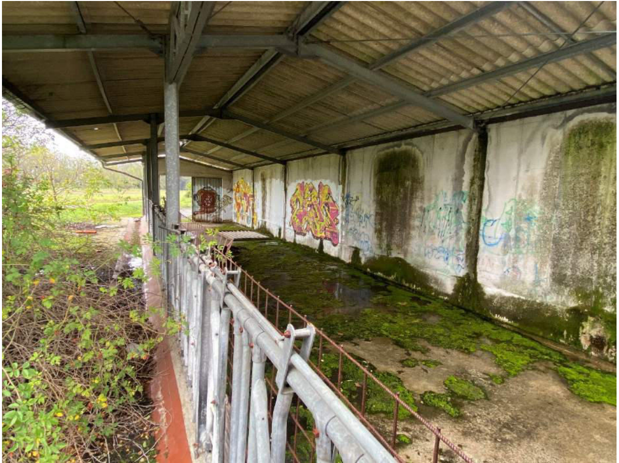
Foto 11 – Vista interna Tettoia Stalla
