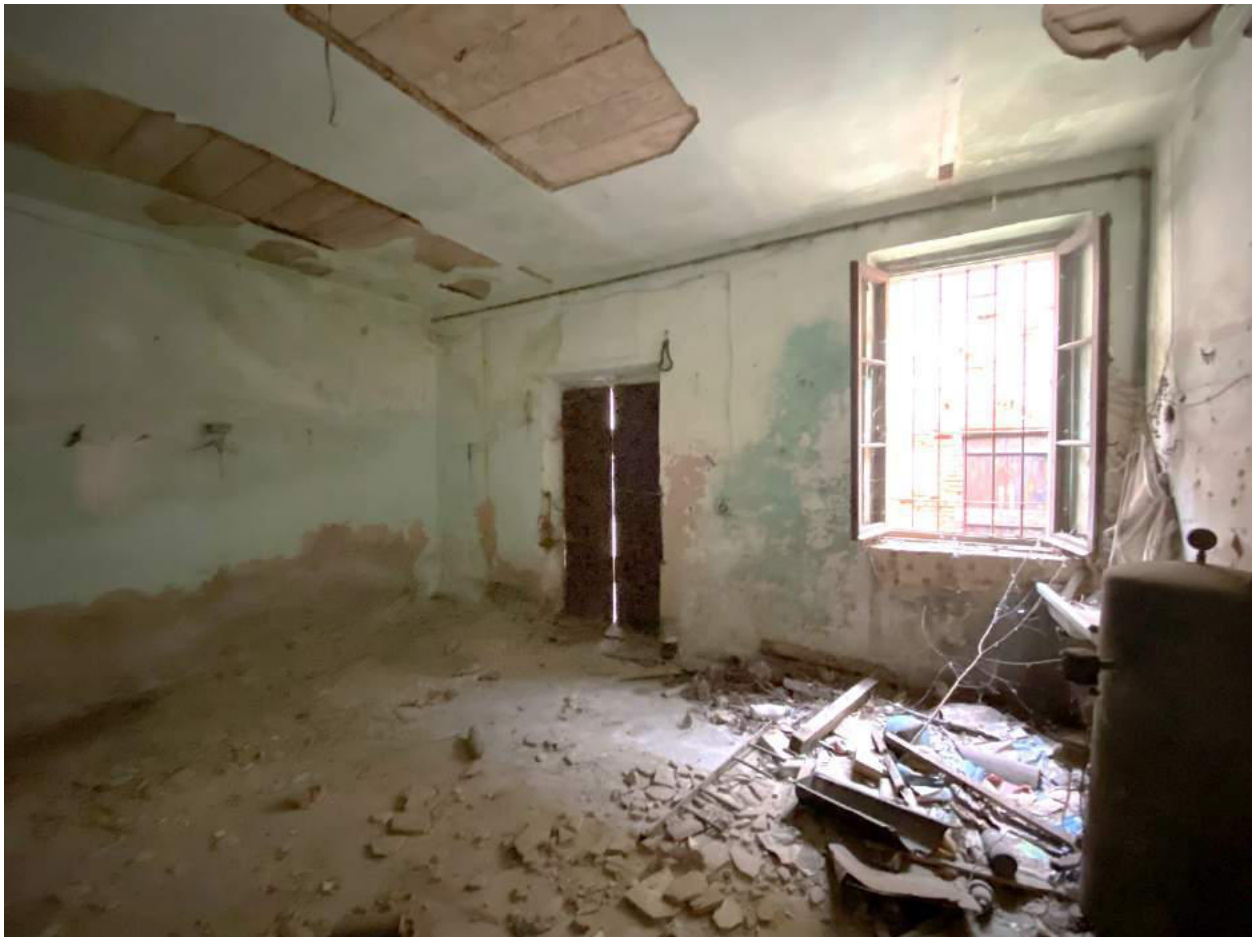
Foto 06 – Vista Interna PT Cucina
