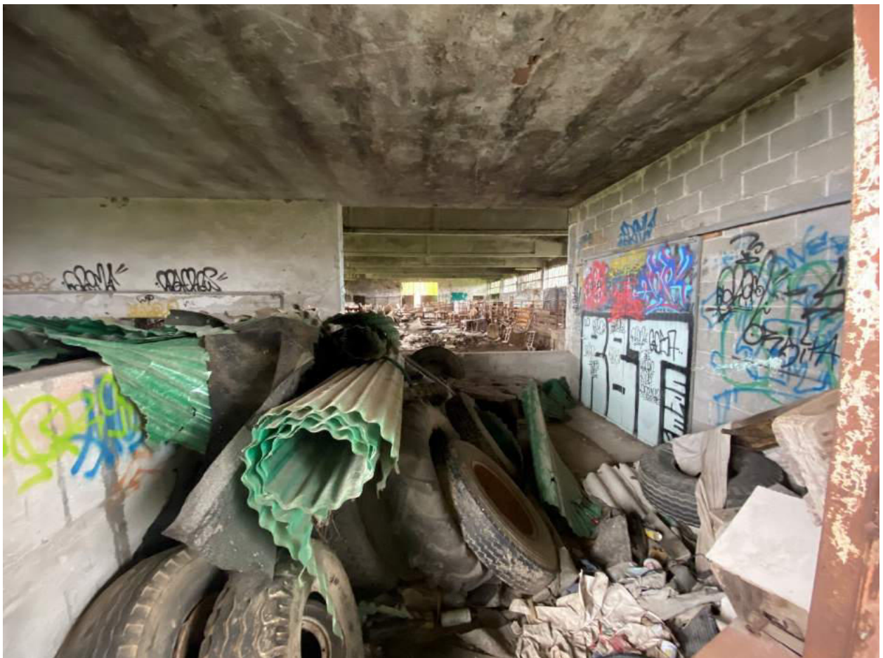
Foto 06 – Vista Interna Dep.Fienile
