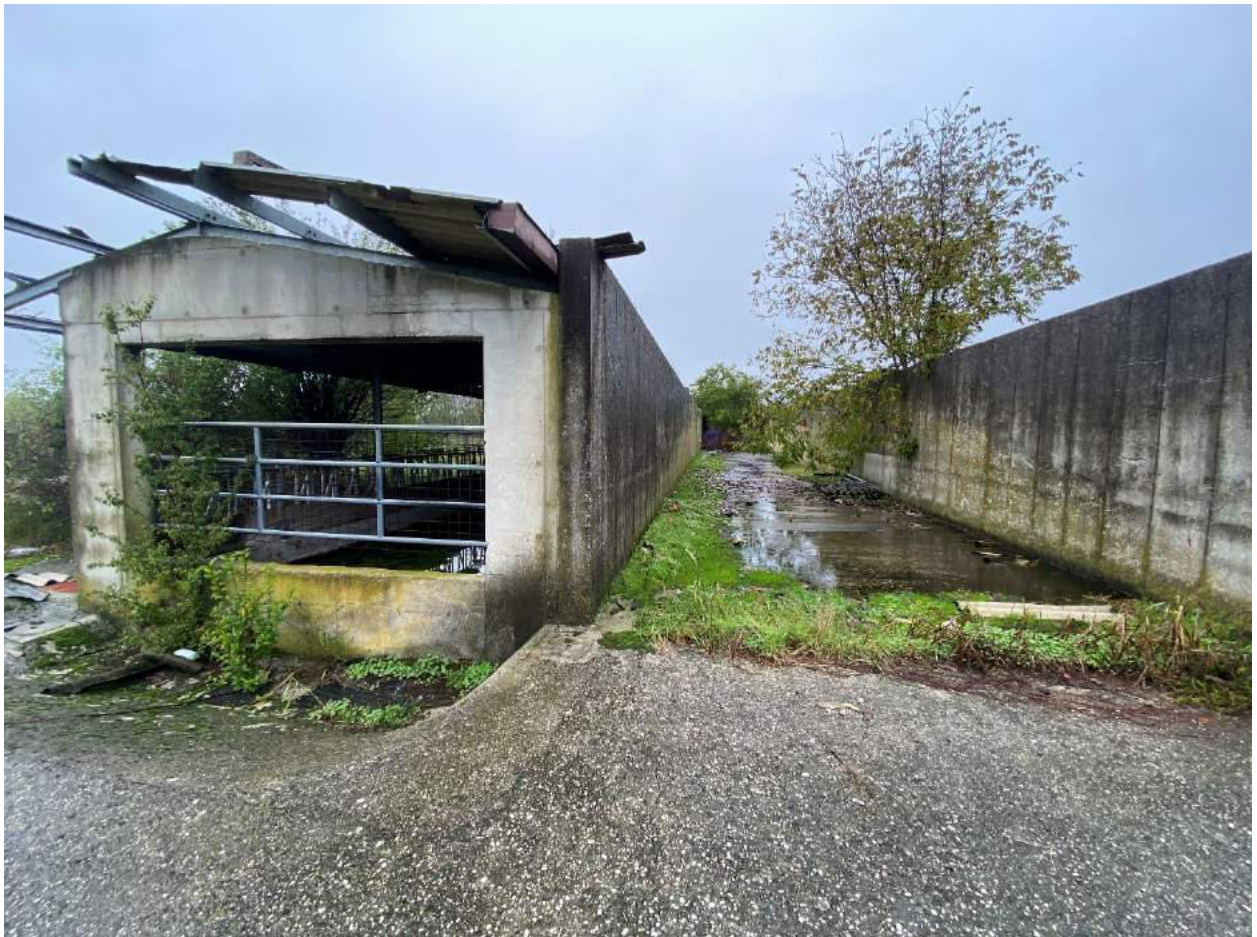
Foto 10 – Vista esterna Tettoia Stalla e Silo Orizzontale
