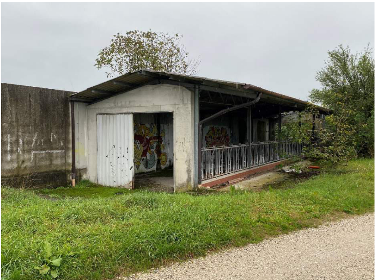
Foto 12 – Vista esterna Tettoia Stalla
