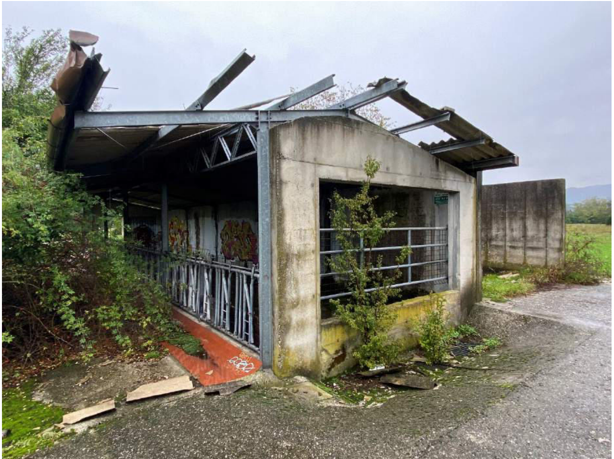
Foto 09 – Vista esterna Tettoia Stalla
