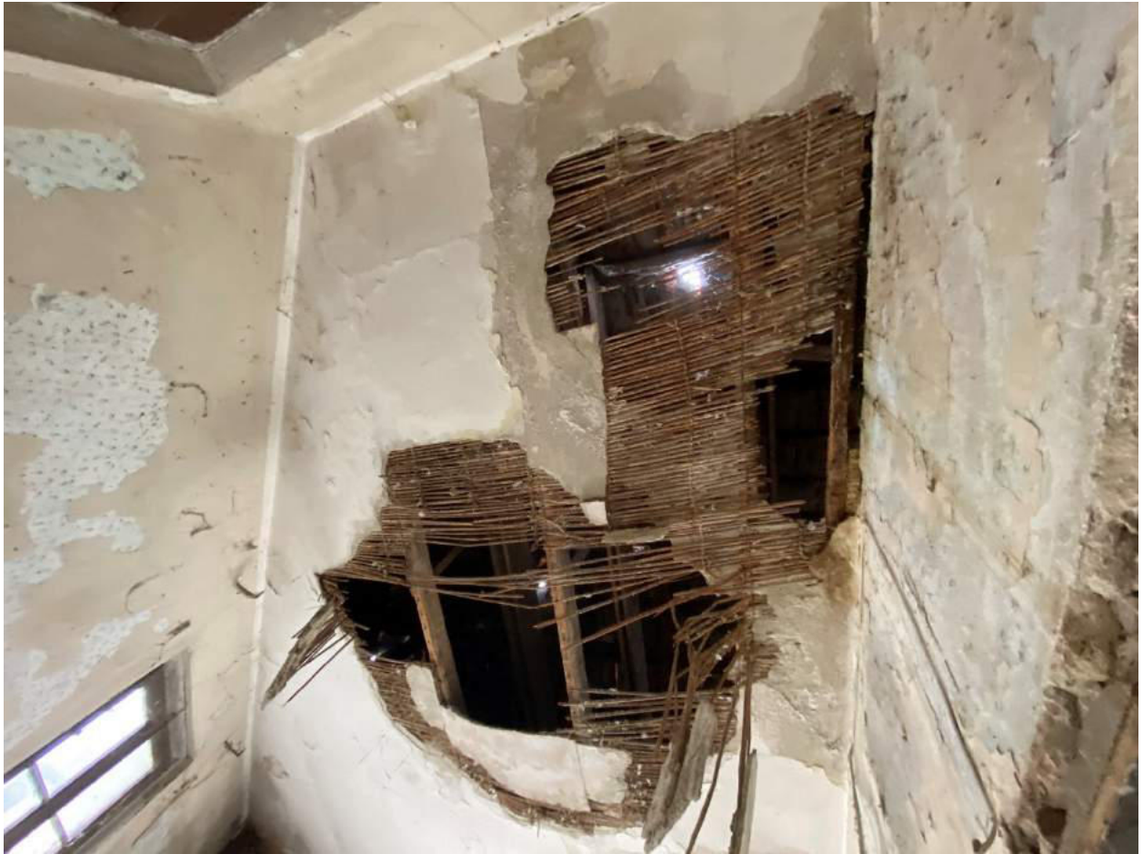
Foto 09 – Vista interna soffitto Camera1
