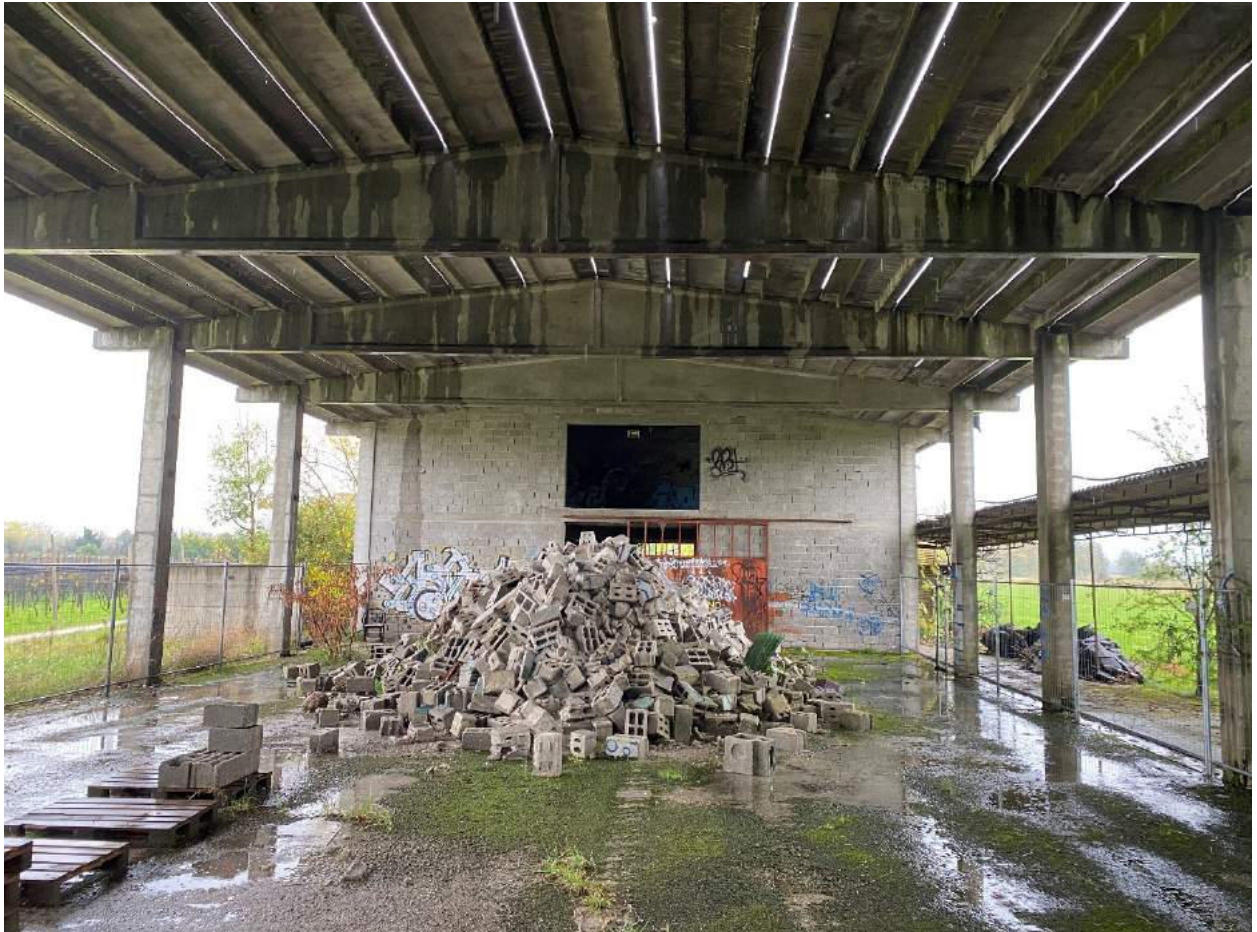
Foto 05 – Vista Interna Dep.Fienile
