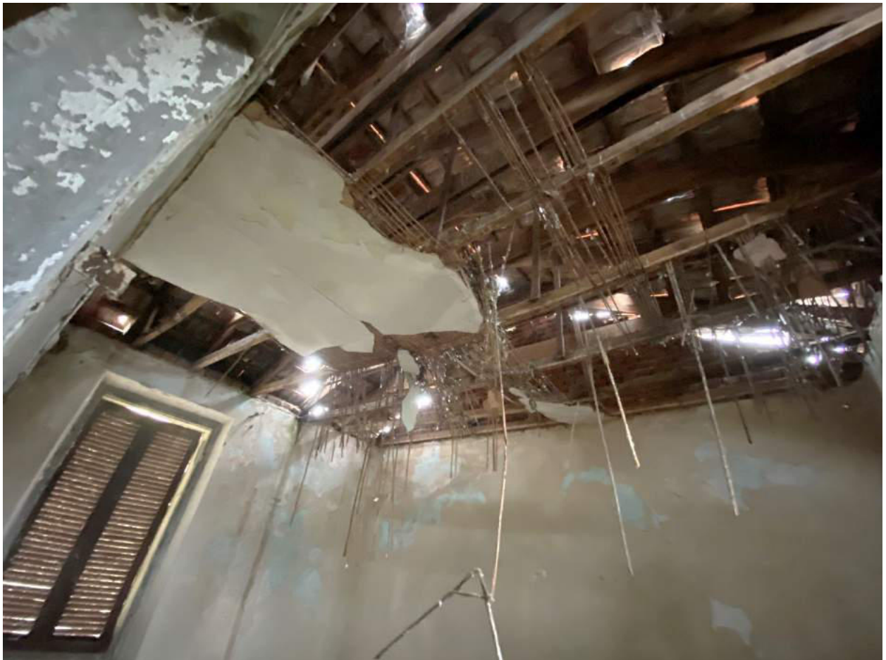
Foto 10 – Vista interna soffitto Camera2
