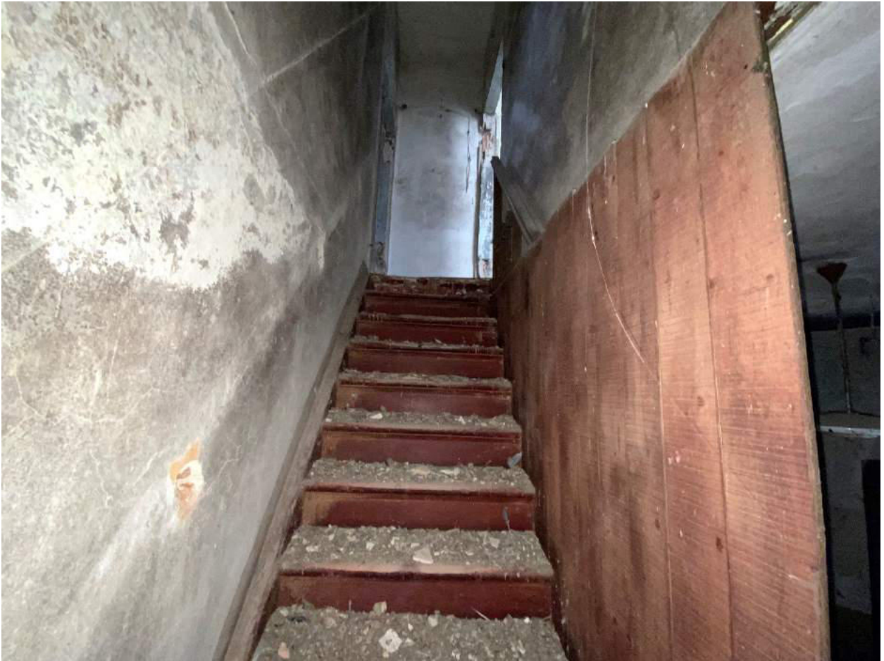
Foto 07 – Vista Interna scala PT/P1
