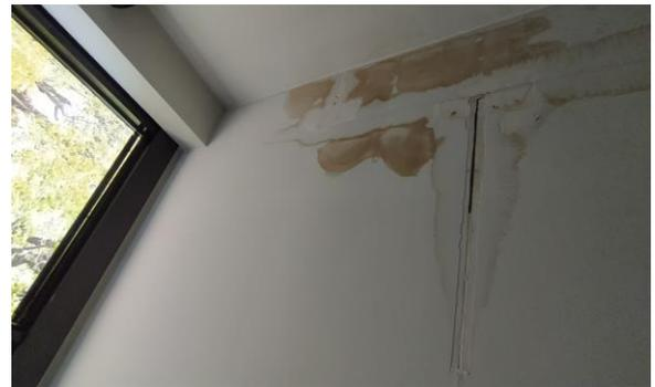
Segni di infiltrazione d'acqua nel soffitto degli uffici al piano primo
