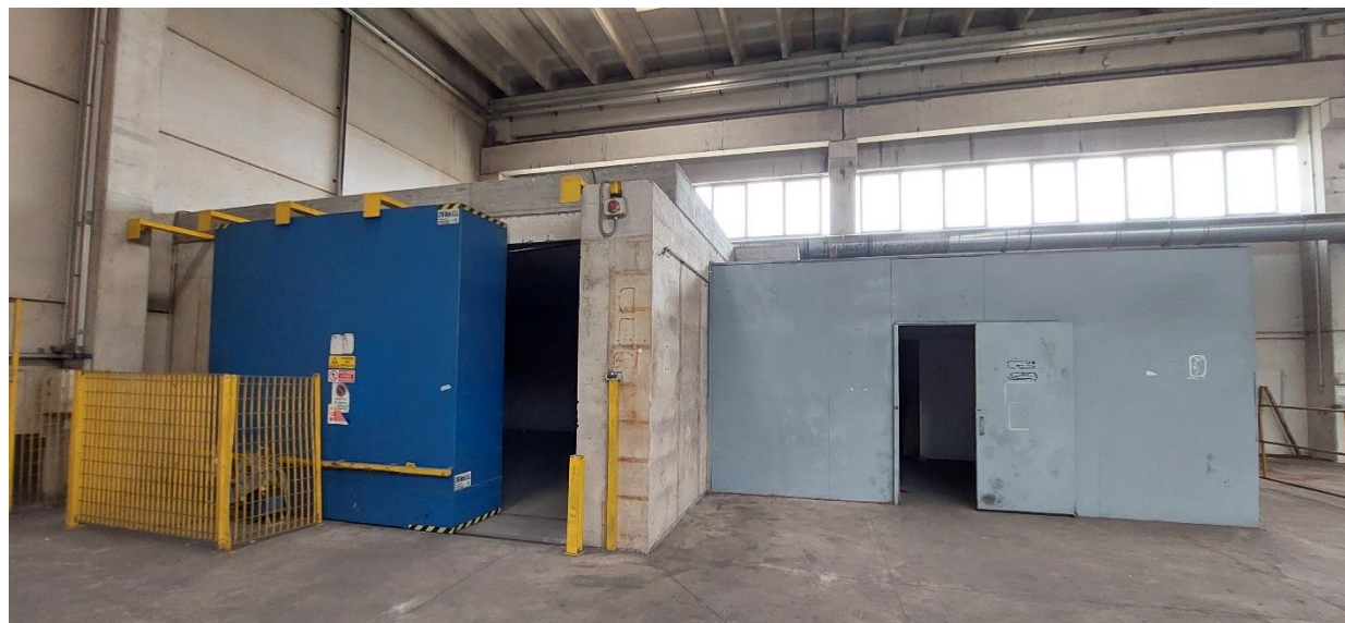
Foto del bunker oggetto del controllo.
